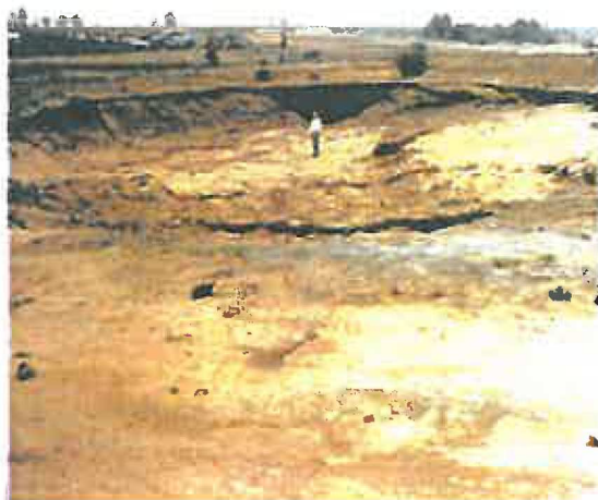
Exemple et conséquences en surface d'un effondrement généralisé
